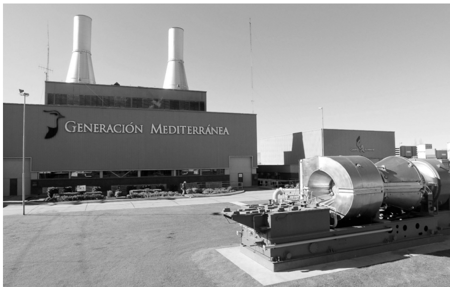
'MODESTO MARANZANA'. CENTRAL TERMOELECTRICA DE RIO CUARTO.
